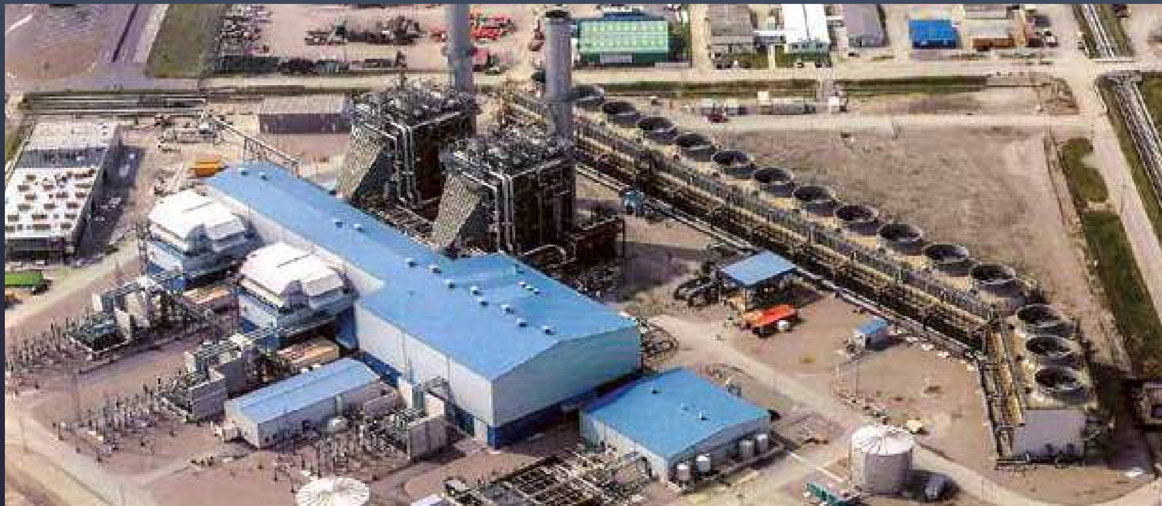
RIJNMOND CCPP 770 MW
